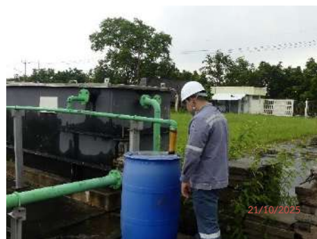
รูปที่ 2.2-5 การตรวจสอบสภาพ Oil Separator
